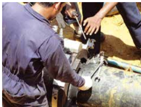
DLW utilizada on-site em gasoduto
